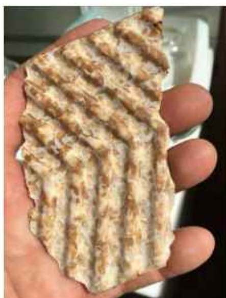
Vodní kámen z deskového výměníku
